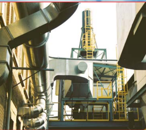
Hochleistungsabsorber für 36.000 m 3 /h. High-performance scrubber for 36,000 m 3 /h.
