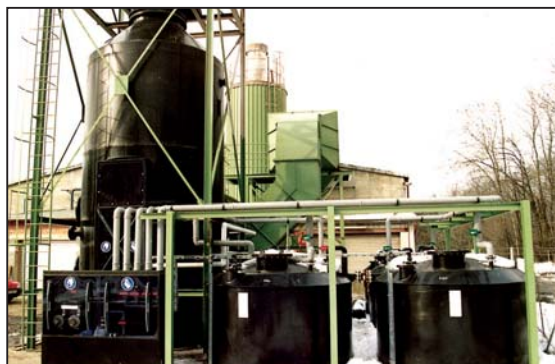
Absorber Typ GKH 32 mit Tankanlage. Scrubber type GKH 32 with tank system.
